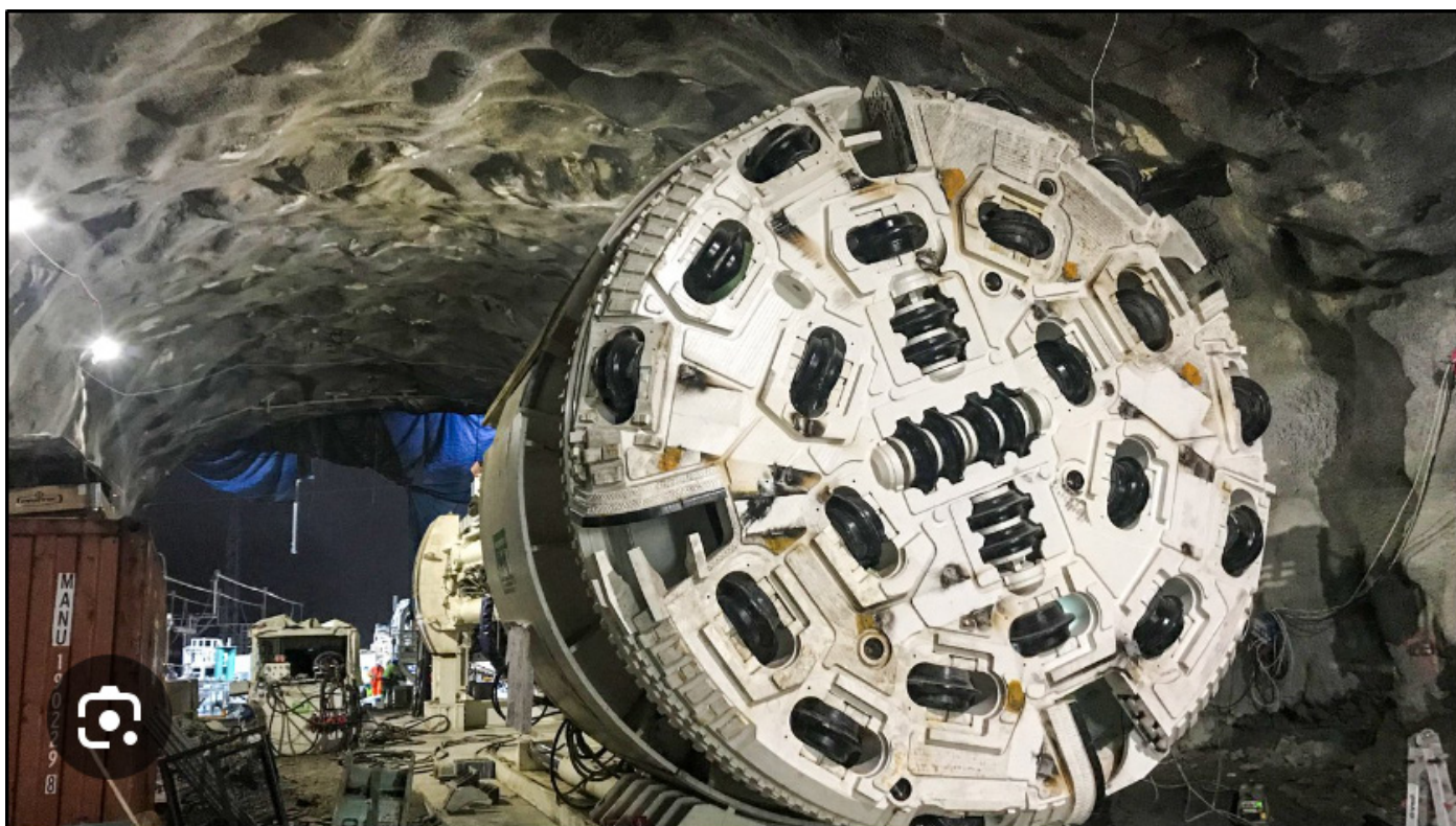
Bild på tunnelbormaskin (TBM) i den aktuella tunneln. Foto: Implen AG.
